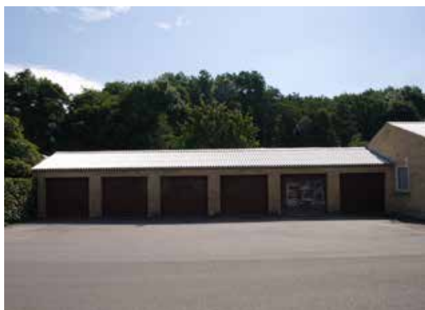
Garager ved det nordlige torv.
