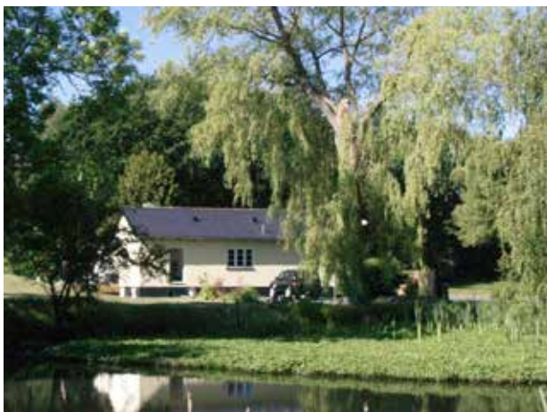
Totalrenoveret bolig sydvest for gadekæret.
